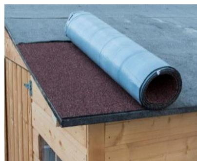
Instalación desde la mitad de la longitud del alero: enrollar la lámina en dos rollos que contengan la mitad de la longitud de la banda ChovASTAR DECK a colocar, de tal forma que el plástico siliconado quede visto y el gránulo oculto. Cortar con un cutter o similar el plástico siliconado, e ir retirando el plástico a medida en que colocamos la banda autoadhesiva del centro a un extremo del faldón. Repetir el proceso del centro al otro extremo.
