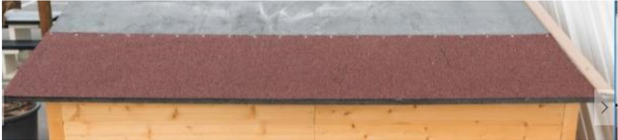
5. Aplicar una presión uniforme con rodillo para asegurar el contacto en toda la superficie de la banda de lámina con el soporte. Aplicar el rodillo de de un extremo al otro.
